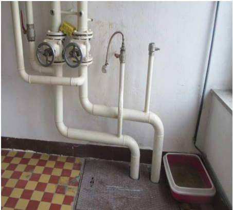
NAPOJENÍ NA STÁVAJÍCÍ ROZVOD ÚT V PRADELNĚ
